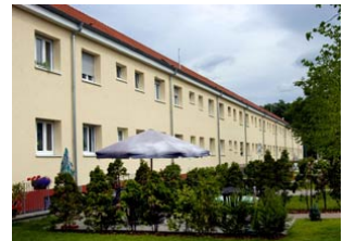
Brennstoffzellen eignen sich ganz besonders zur Versorgung von Reihenhäusern mit Strom und Wärme. (Bild: MVV)
